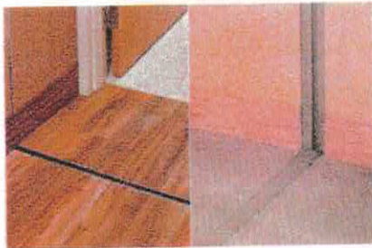
Junta en piso y muro.
