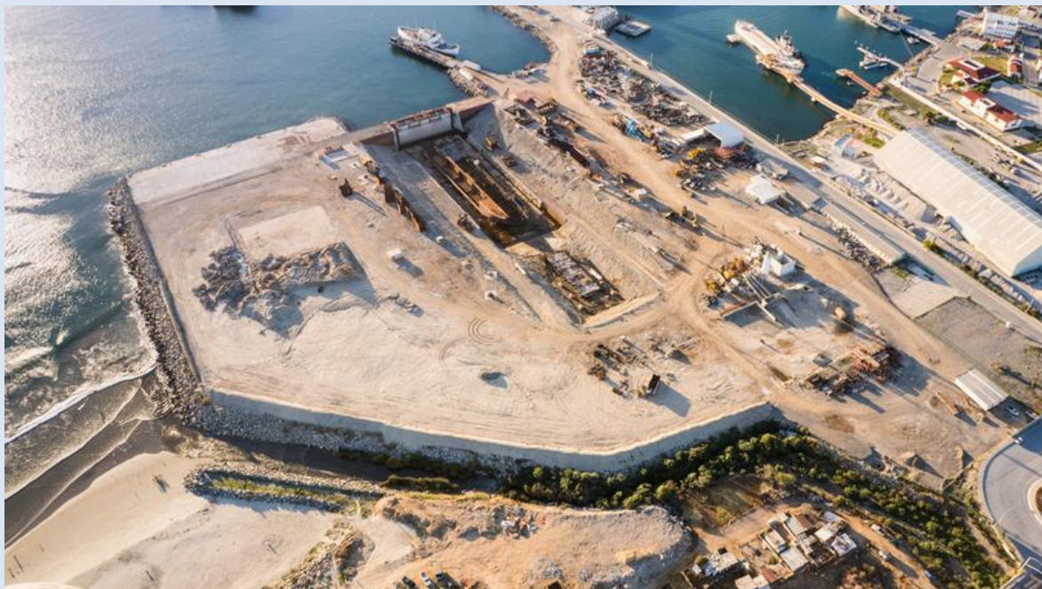
Vista general de las instalaciones Imagen obtenida de la web de la empresa
