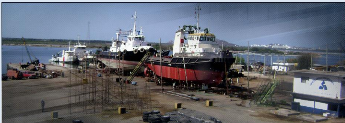
Trabajos de reparación de dos remolcadores de PEMEX Imagen obtenida de la web de la empresa
