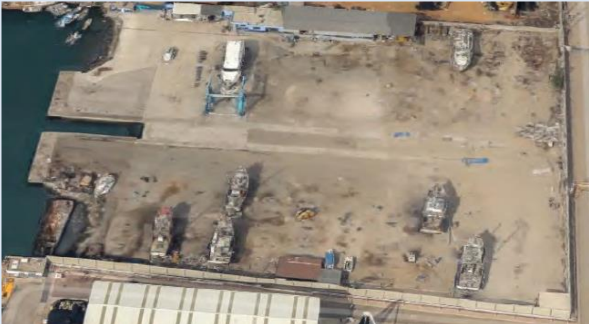
Vista aérea de las instalaciones Imagen obtenida de proyecto “Desarrollo Integral Sostenible de Innovación y Tecnología de la Industria Naval y Auxiliar, “CORE” del Sector Marítimo Mexicano”
