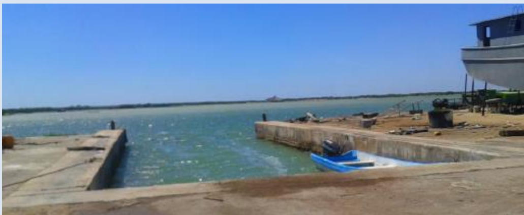
Dársena para levantamiento de embarcaciones Imagen obtenida del proyecto “Desarrollo Integral Sostenible de Innovación y Tecnología de la Industria Naval y Auxiliar, “CORE” del Sector Marítimo Mexicano”
