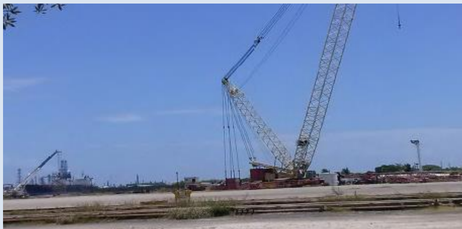
Patio de construcción BOSNOR
