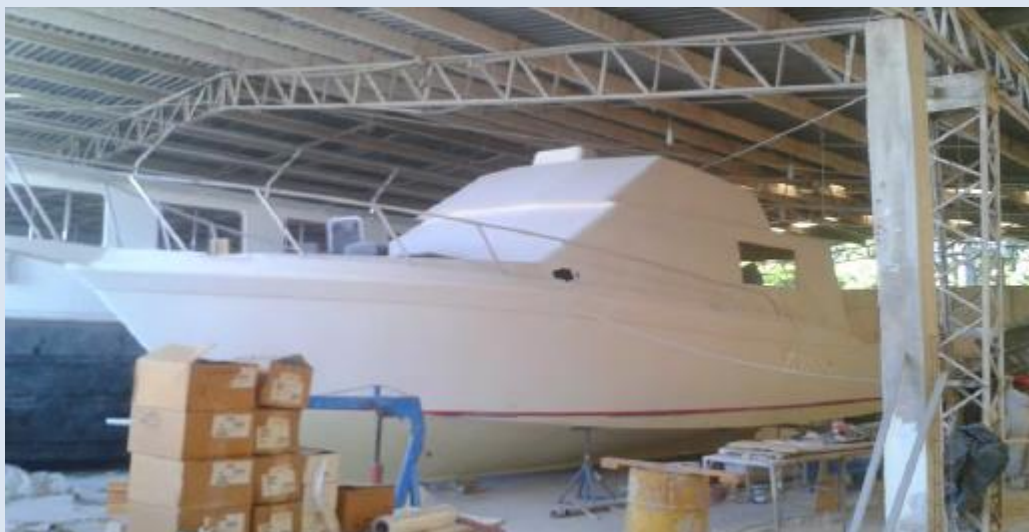
Embarcación en proceso de construcción Imagen obtenida del proyecto “Desarrollo Integral Sostenible de Innovación y Tecnología de la Industria Naval y Auxiliar, “CORE” del Sector Marítimo Mexicano”
