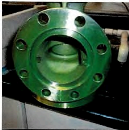
Limpeza y aplicación de líquido penetrante
