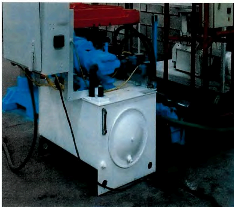
Acondicionamiento de sistema hidráulico
