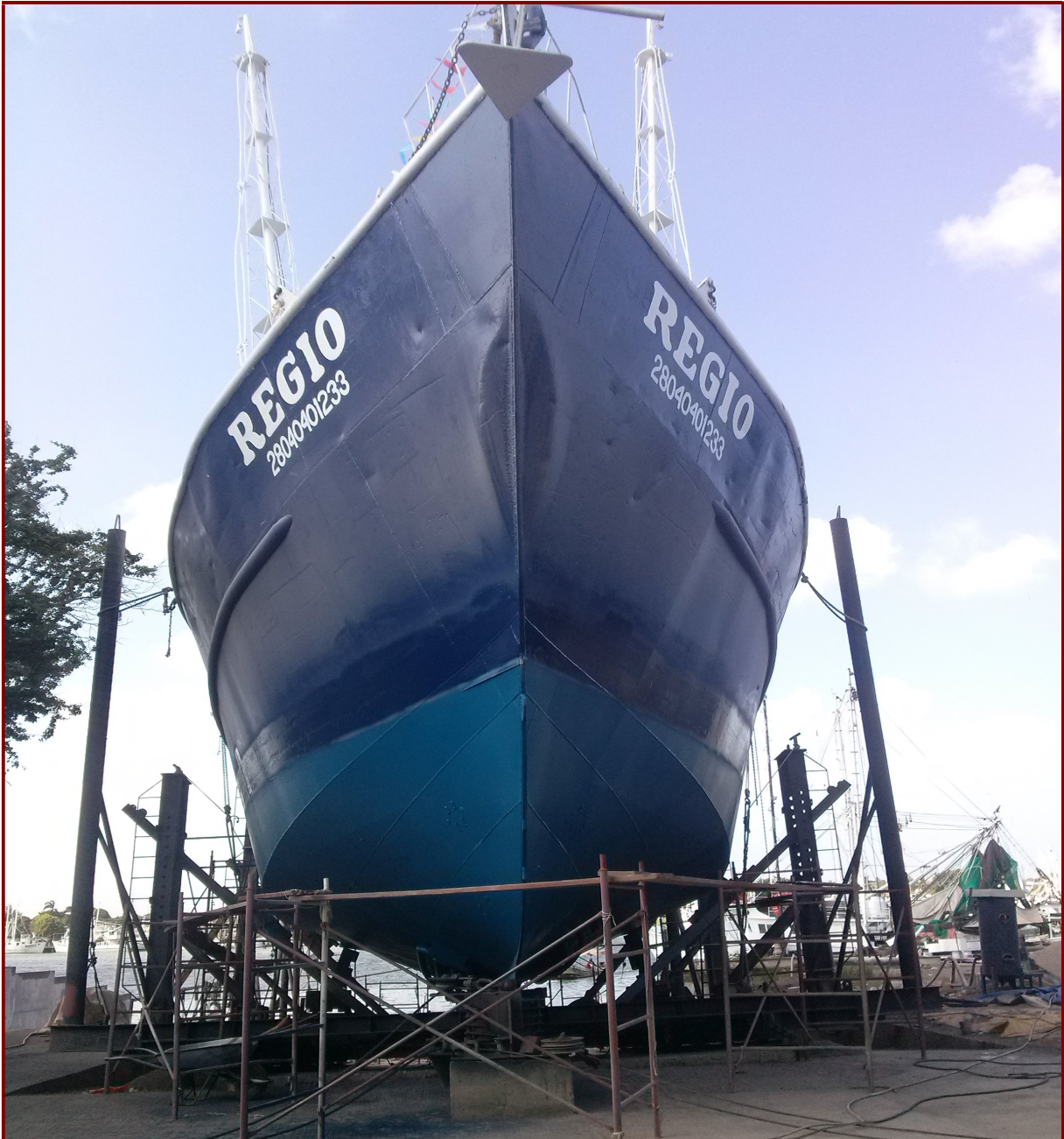
IMAGEN 32: BARCO CAMARONERO “REGIO” EN REPARACIÓN.
