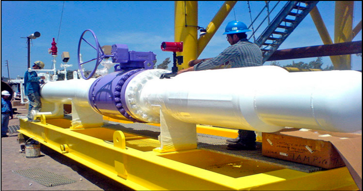
IMAGEN 10: CONSTRUCCION DE TUBERÍA EN PROCESO.
