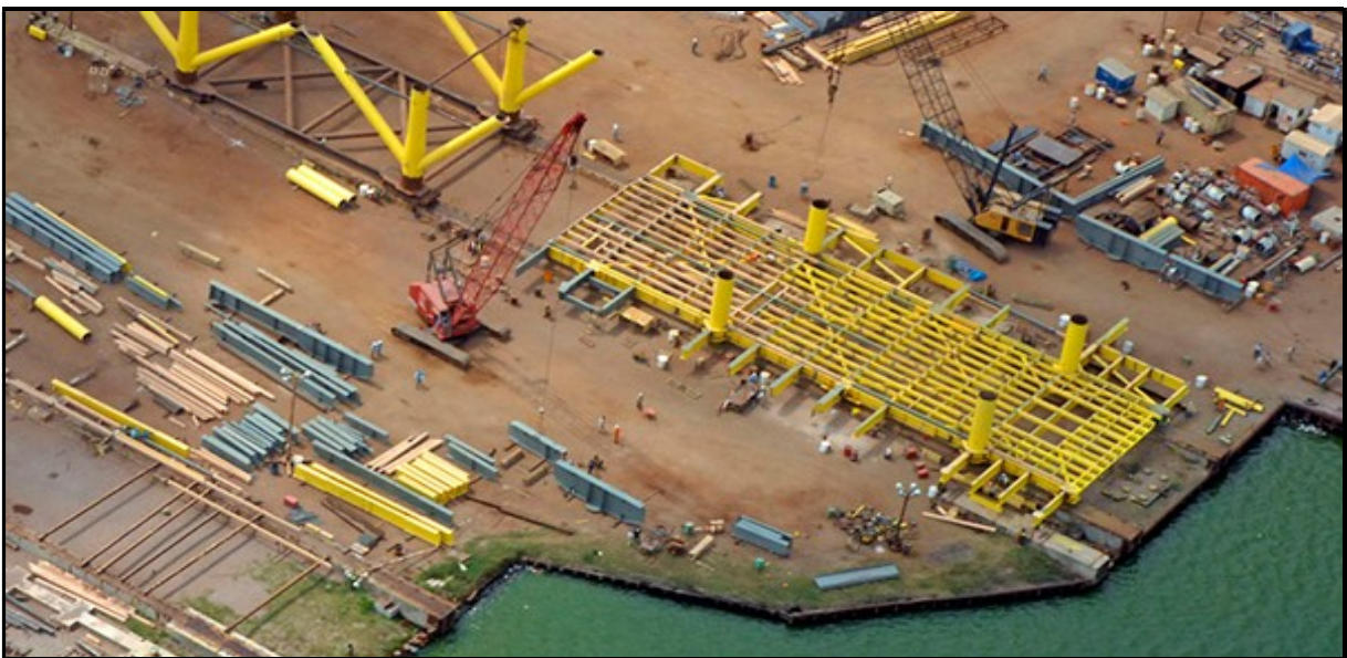
IMAGEN 9: CONSTRUCCION DE UN JACKET PARA PLATAFORMA
