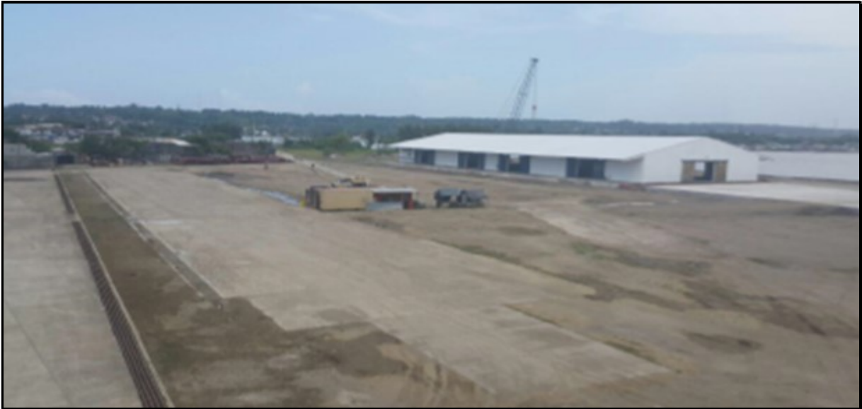
IMAGEN 13: PATIO DE FABRICACIÓN.
