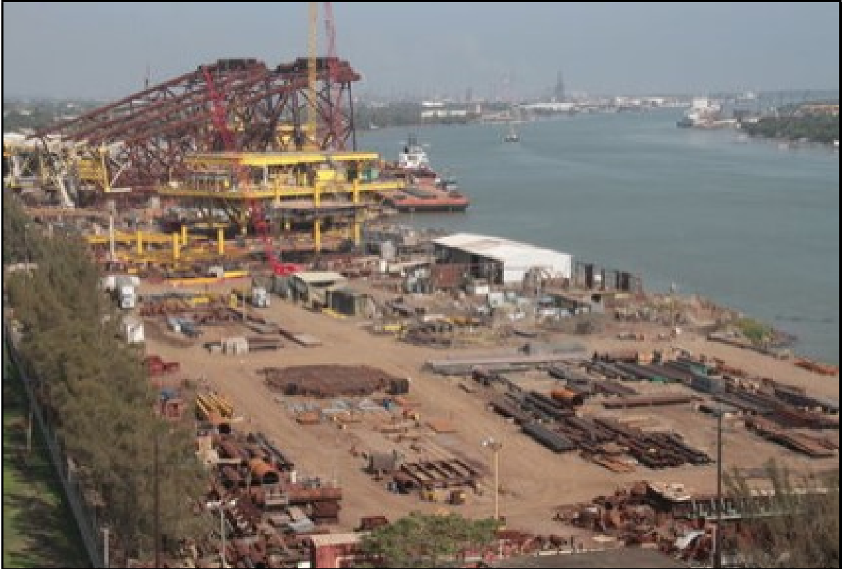
IMAGEN 12: VISTA GENERAL DEL PATIO DE CONSTRUCCIÓN.
