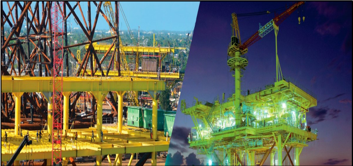
IMAGEN 8: PLATAFORMAS CONSTRUIDAS EN EL PATIO.
