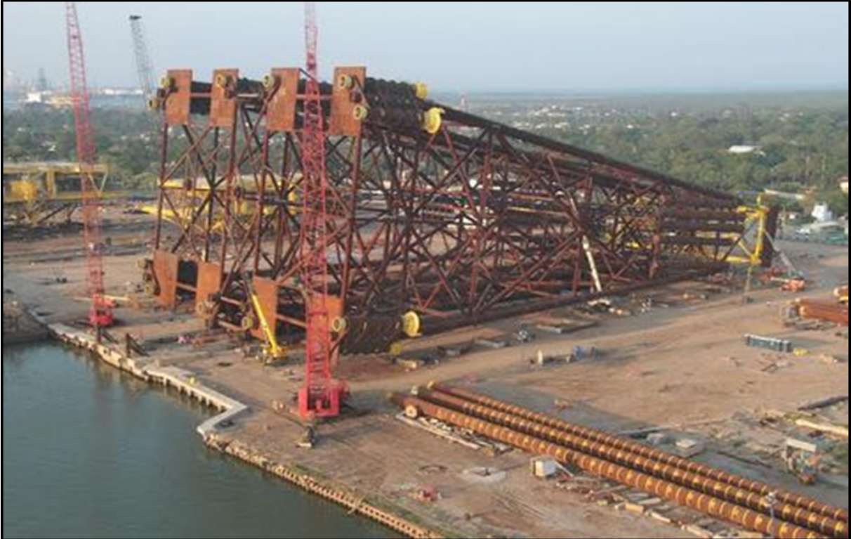
IMAGEN 16: CONSTRUCCIÓN DE PLATAFORMA EN EL PATIO.
