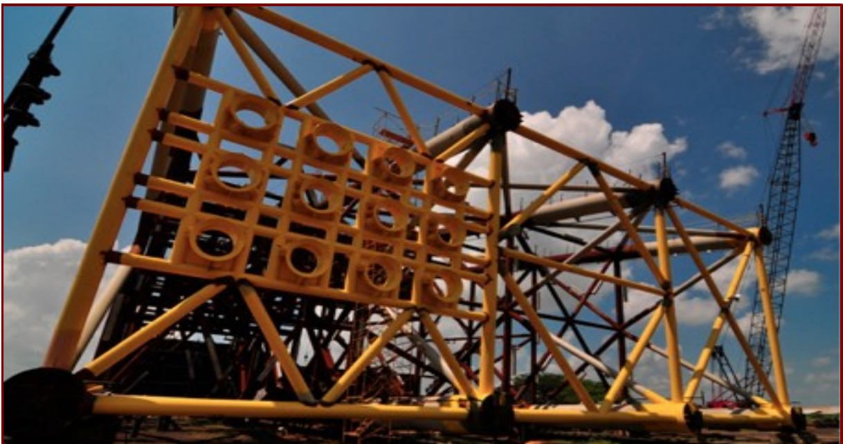
IMAGEN 11: CONSTRUCCIÓN DE PLATAFORMA.
