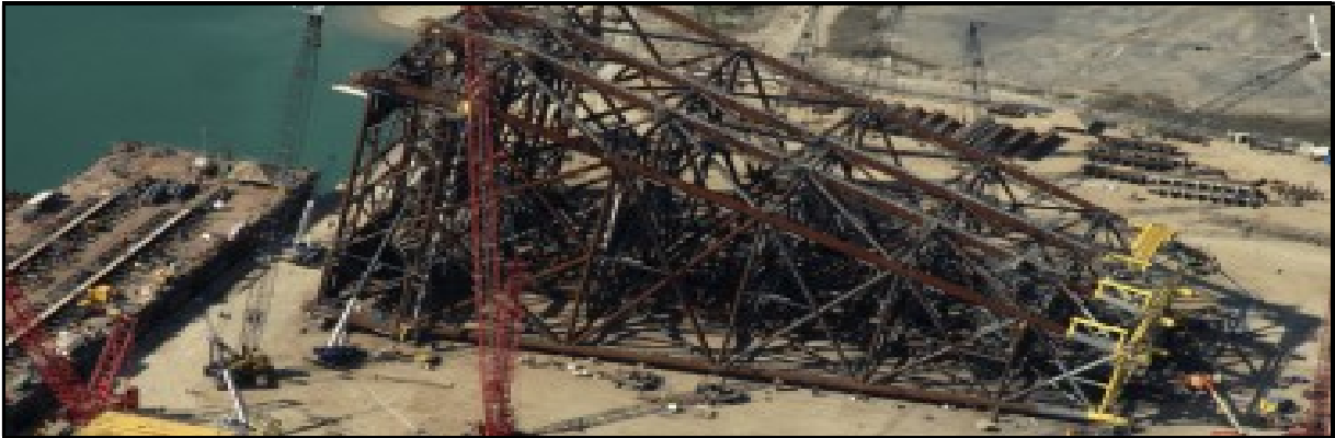
IMAGEN 1: CONSTRUCCIÓN DE JACKET DE PLATAFORMA.
