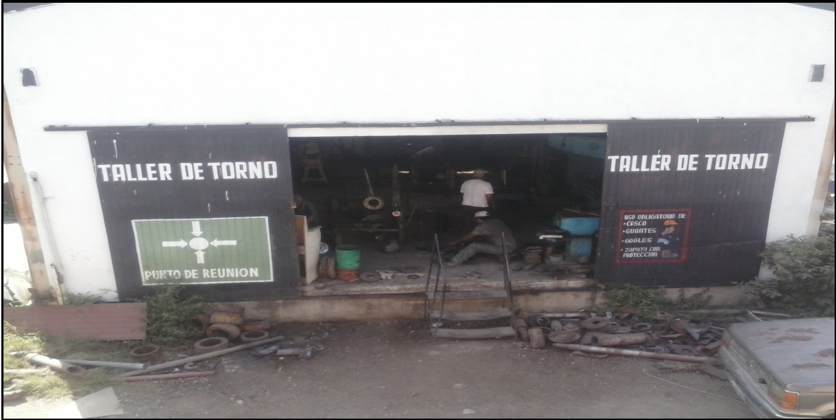
IMAGEN 5: TALLER MECÁNICO Y DE SOLDADURA.
