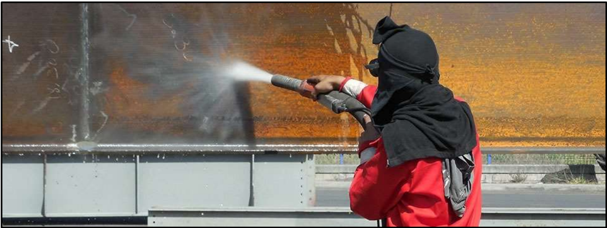
Figura 29, Limpieza con chorro abrasivo.
