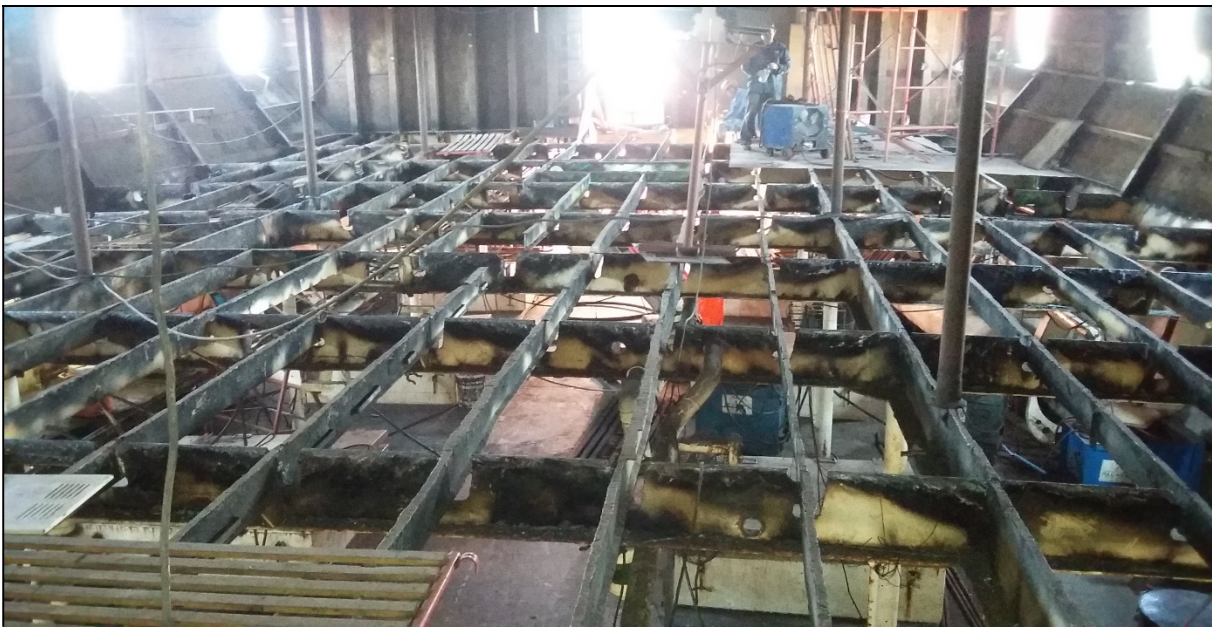
IMAGEN 83: RENOVACIÓN DE ACERO EN CUBIERTA
