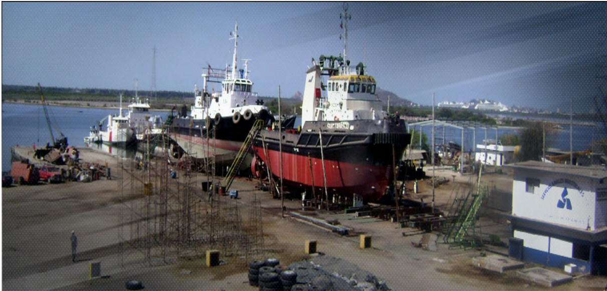
IMAGEN 85: TRABAJOS DE REPARACIÓN DE DOS REMOLCADORES DE PEMEX
