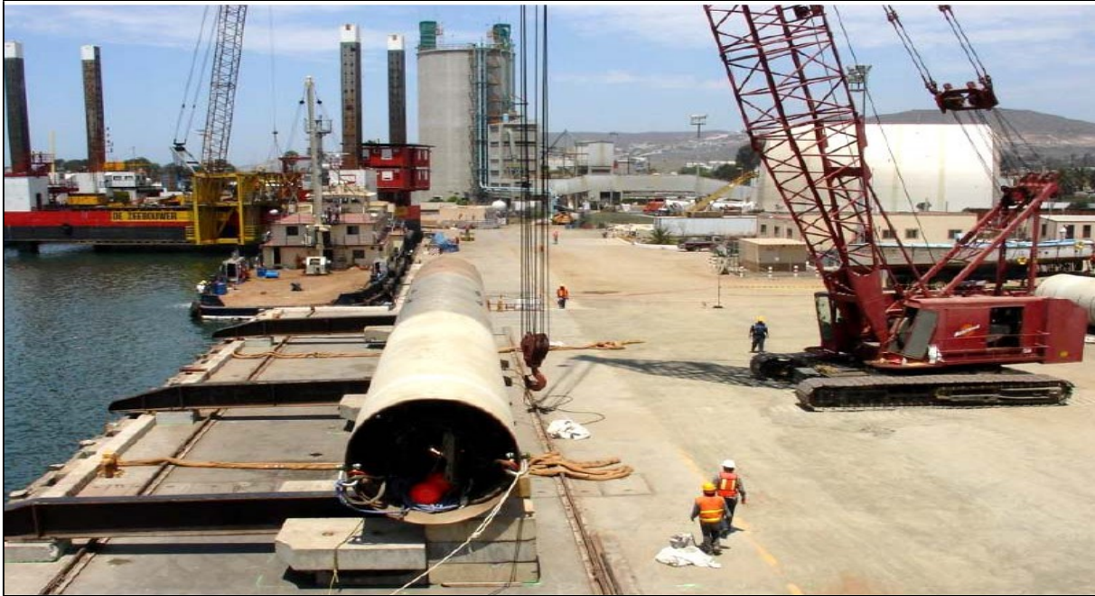
IMAGEN 42: PATIO DE MANIOBRAS.
