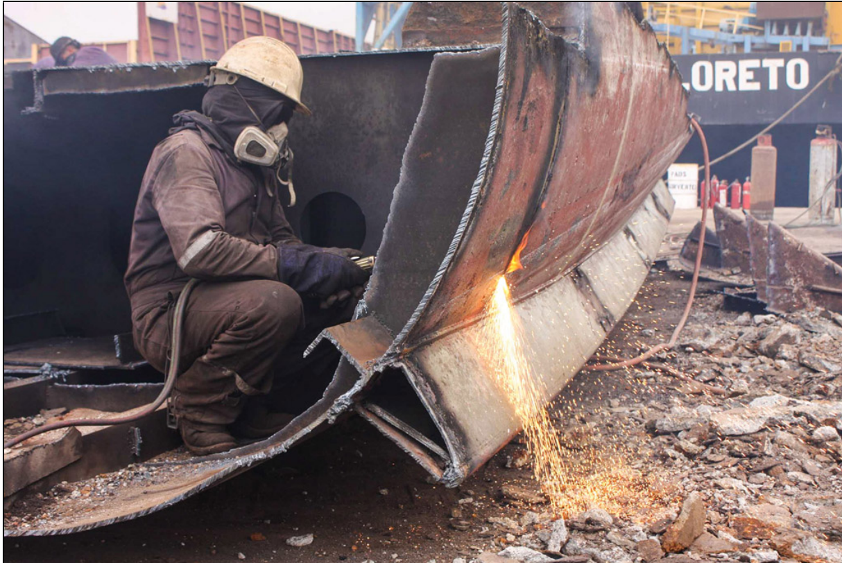
IMAGEN 36: PAILERO EN OBRA DE DESGUACE.
