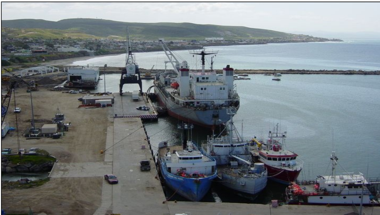
IMAGEN 41: MUELLE DE REPARACION A FLOTE.
