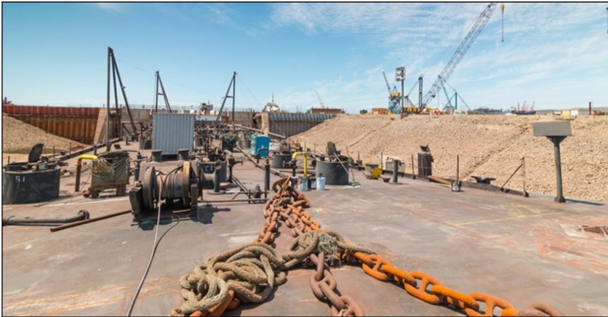
IMAGEN 33: EQUIPO DE AMARRE Y ARRASTRE SOBRE LA LOSA DEL DIQUE SECO.
