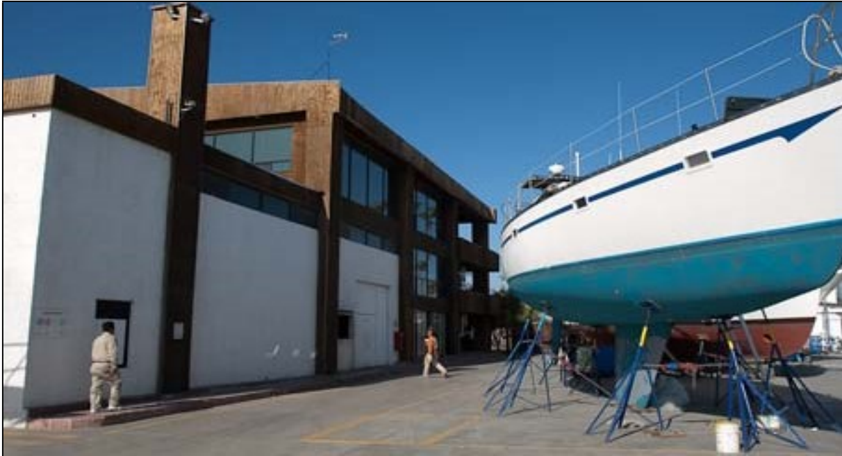
IMAGEN 10: PATIO SECO PARA EMBARCACIONES.
