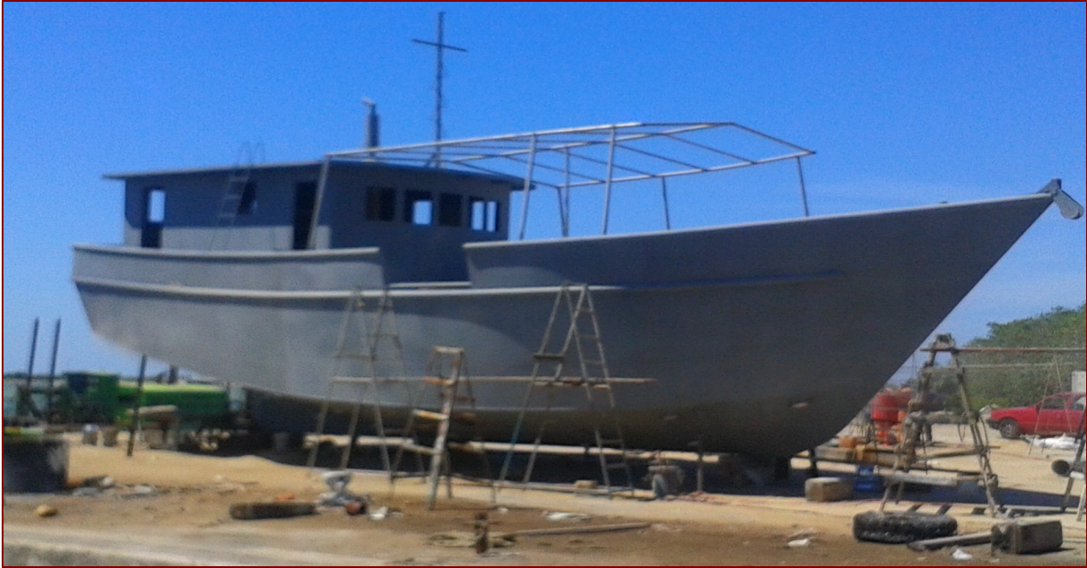
IMAGEN 159: EMBARCACIÓN EN PROCESO DE APLICACIÓN DE SAND BLAST.
