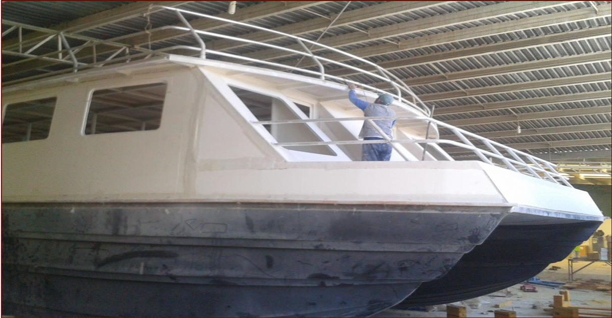
IMAGEN 168: CATAMARÁN EN PROCESO DE CONSTRUCCIÓN.
