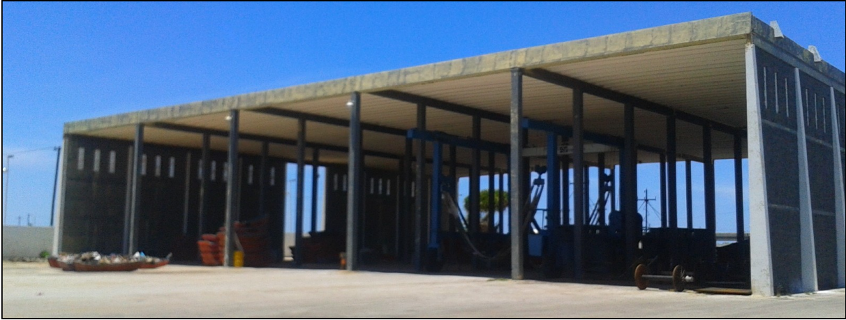
IMAGEN 145: NAVE DE CONSTRUCCIÓN.
