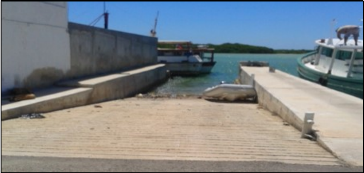
IMAGEN 122: RAMPA DE LANZAMIENTO.
