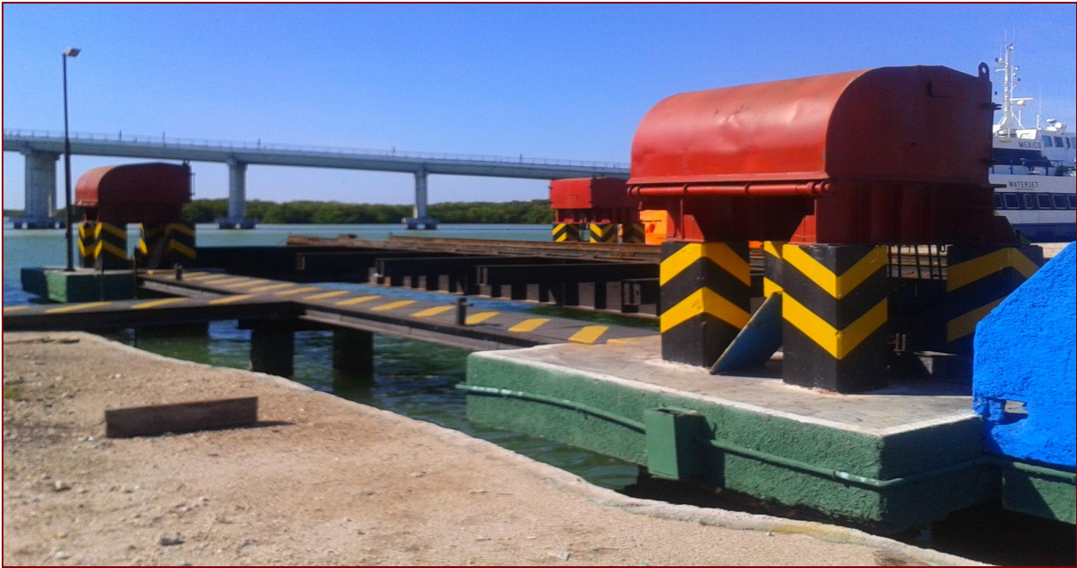
IMAGEN 128: SINCROELEVADOR MOSTRANDO WINCHES DE ELEVACIÓN.
