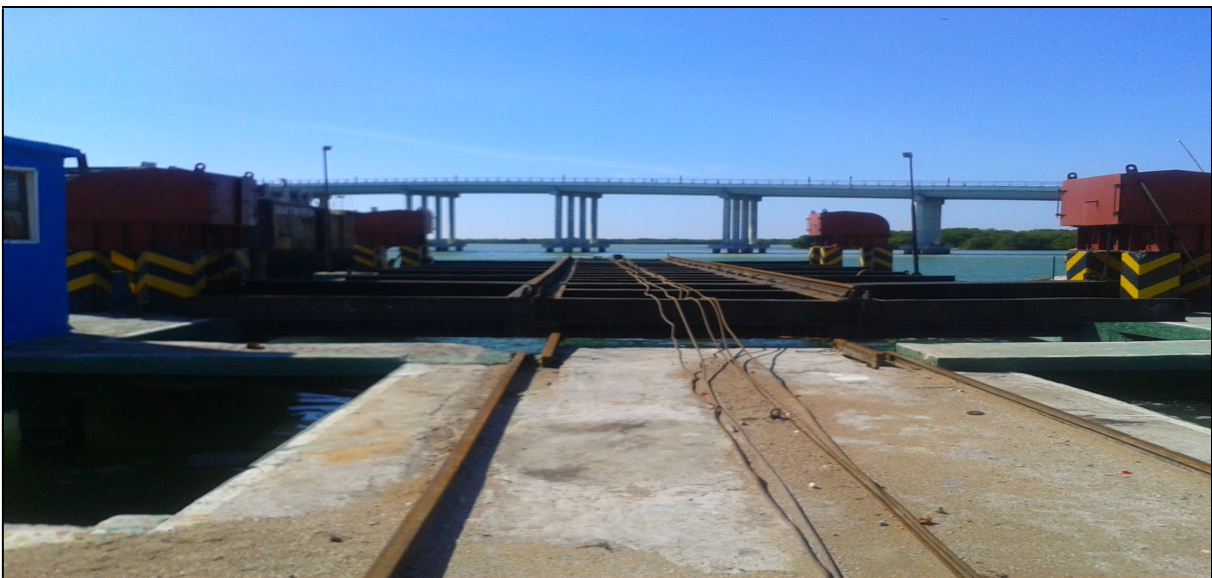
IMAGEN 129: SINCROELEVADOR DE 300 TONELADAS.
