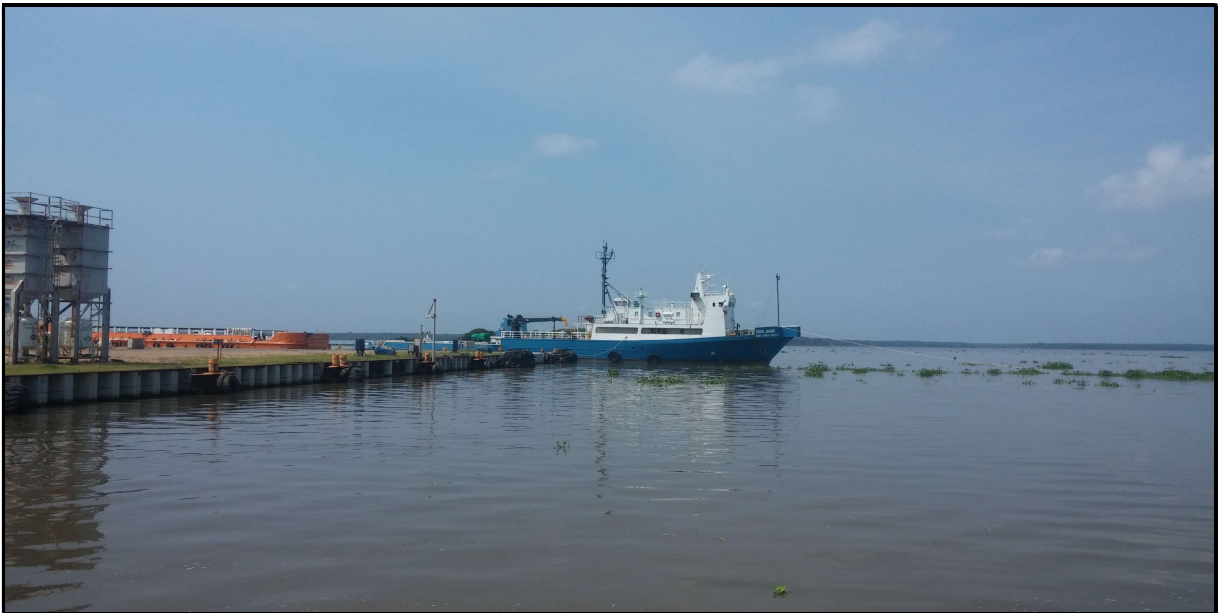
IMAGEN 89: MUELLE DE REPARACIONES.
