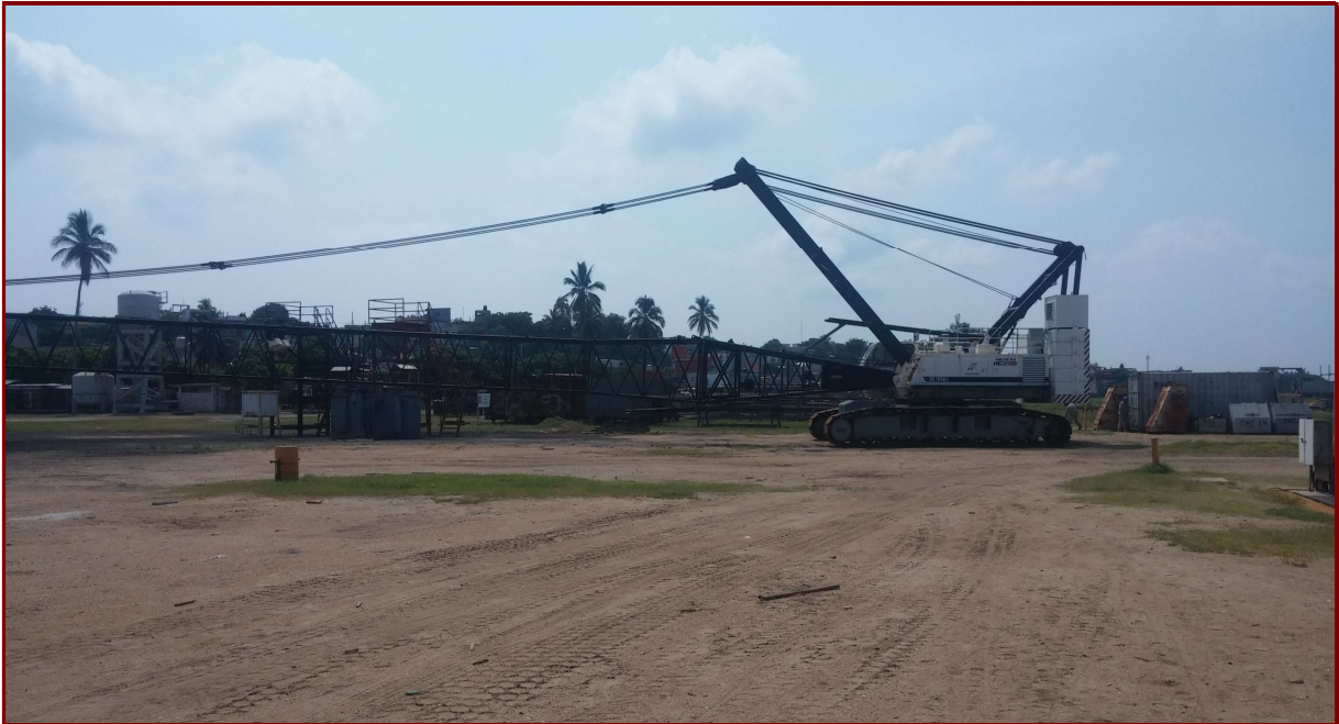
IMAGEN 90: GRÚA CON CAPACIDAD DE 230 TONELADAS.
