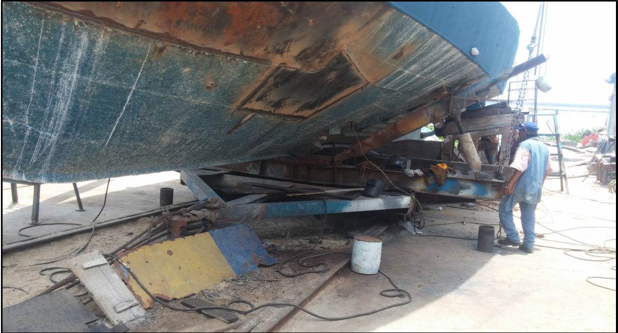
IMAGEN 83: CAMBIO DE ACERO.
