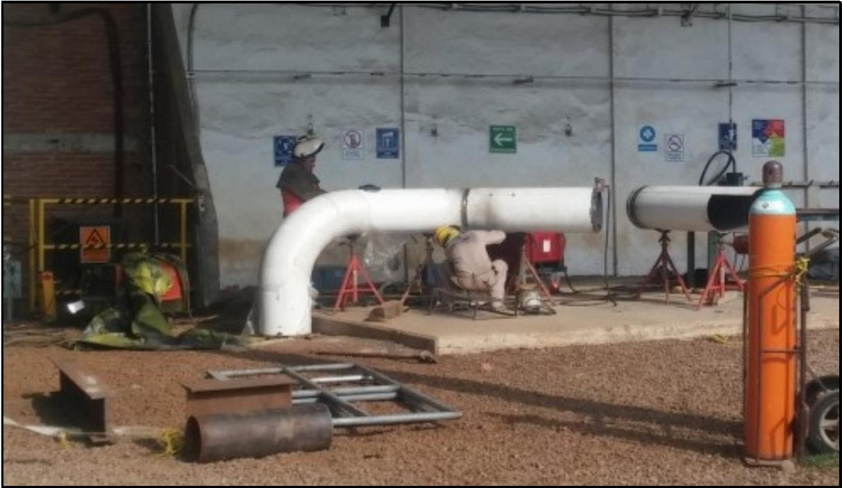
**IMAGEN 61:** TALLER DE SOLDADURA DE TUBERÍA.
