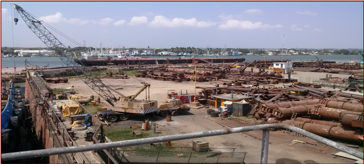
IMAGEN 45: VISTA GENERAL DEL ASTILLERO.
