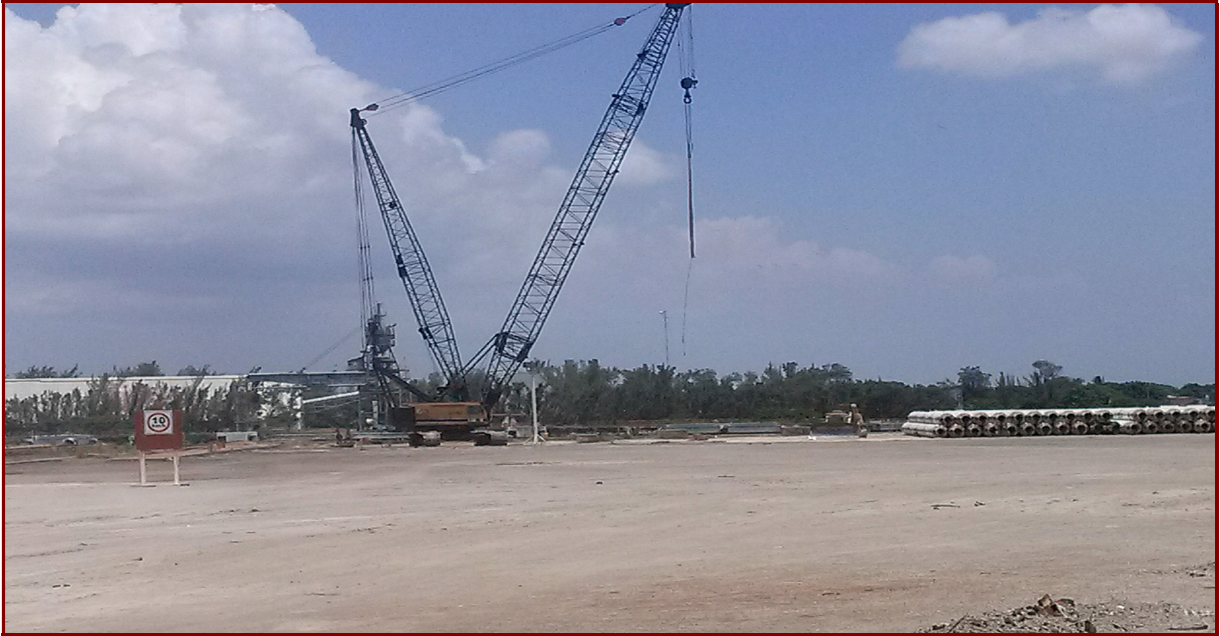
IMAGEN 40: GRÚA TIPO ORUGA.
