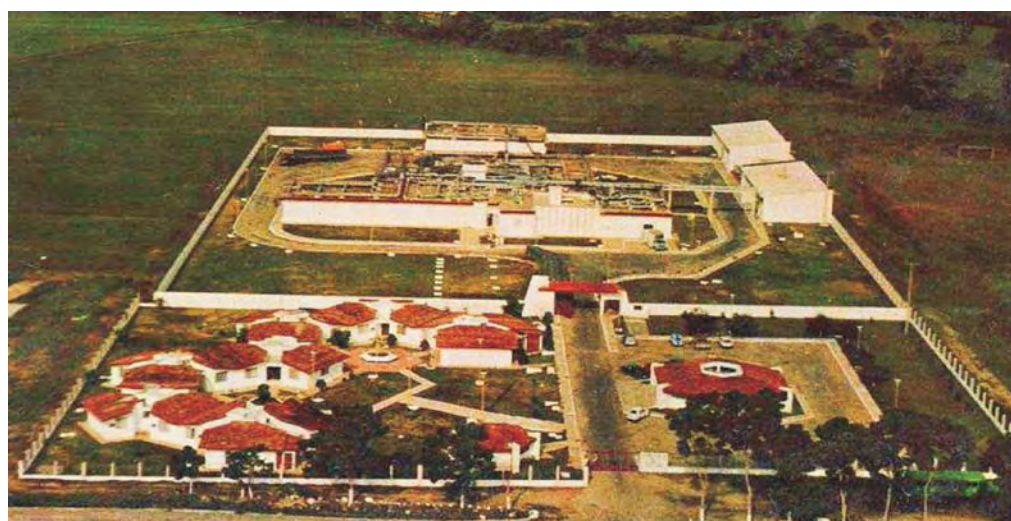
Figura II.4. Planta Moscamed en construcción
