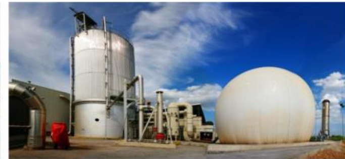
TMB – segregação das embalagens e biodigestão seca dos orgânicos
