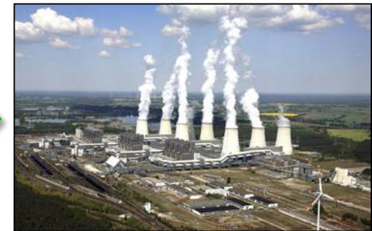
Central Eléctrica a Carbón
