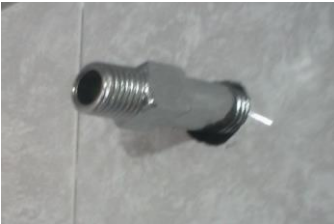
Imagen 13: Colocación del cople.
