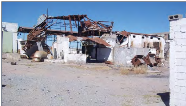
Edificios en ruinas en el sitio "La Fundidora".
