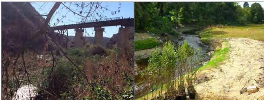
Una sección de la Cuenca del río Tijuana antes del inicio de los trabajos y otra sección después de las actividades de restauración.
