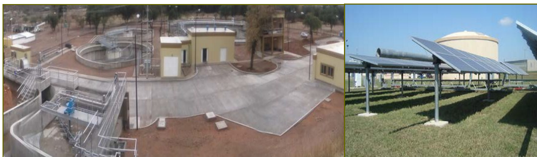
Planta de Tratamiento de Aguas residuales Los Alisos y su planta de energía solar.
