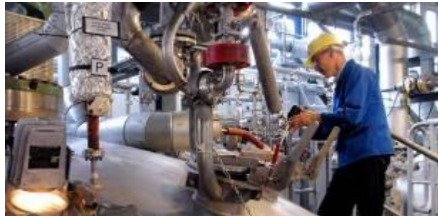
Ilustración 103 Realización de mantenimiento
