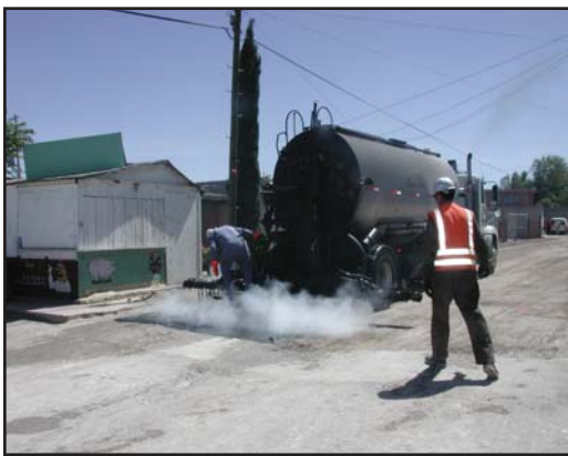
Asfalto con caucho pulverizado
