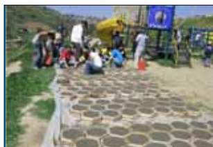
Voluntarios acomodan losetas que permiten que el agua se filtre a través del pavimento y canalizan los escurrimientos.
