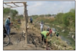
Se realizó la limpieza de 175,500 m2 del Dren “Los Ángeles”.
