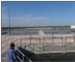
La planta de tratamiento de aguas residuales de Reynosa ha sido terminada y está operando.
