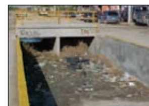
Saneariamiento de Canal (Photo antes).
