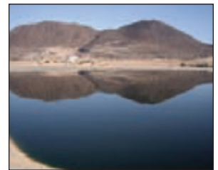
Planta de Tratamiento de Aguas Residuales Las Arenitas.
