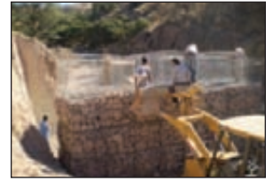
Estructura de detención de agua torrencial.
