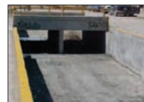
Saneariamiento de Canal (Photo despues).
