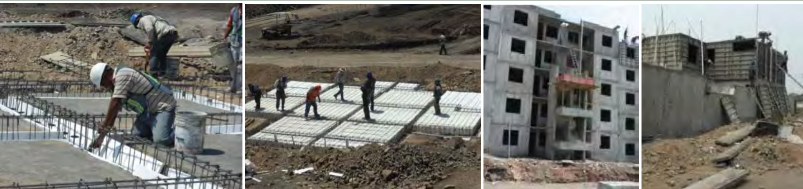
COLADO DE MUROS Y LOSAS DE ENTREPISO EN CONCRETO
