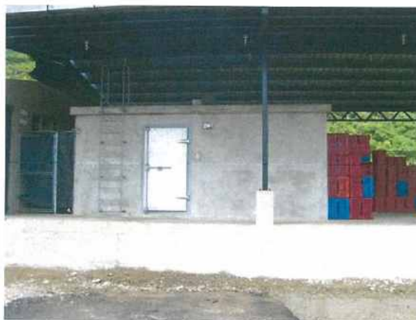
Figura 10. Cámara de fumigación de concreto.
