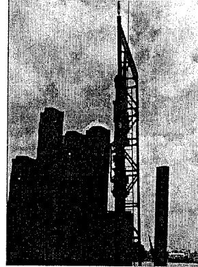
Colocación e hincado de tablestaca
