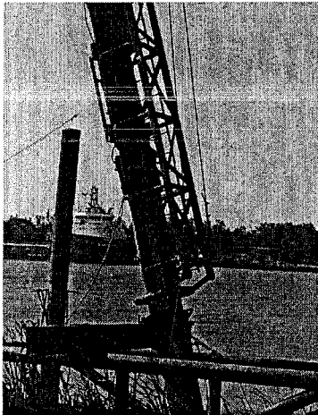
Hincado y descabezado de pilotes
