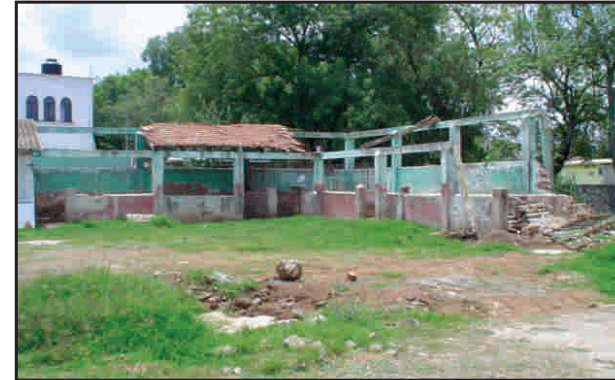
Corrales de observación y descanso en desuso, lo que impide llevar a cabo la inspección ante-mortem adecuadamente. Ubicación del establecimiento en zona urbana.
