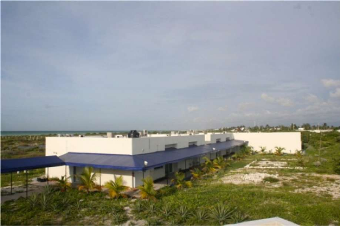
Figura 7. Instalaciones de la Facultad de Química de la Unidad Académica Sisal, UNAM.
