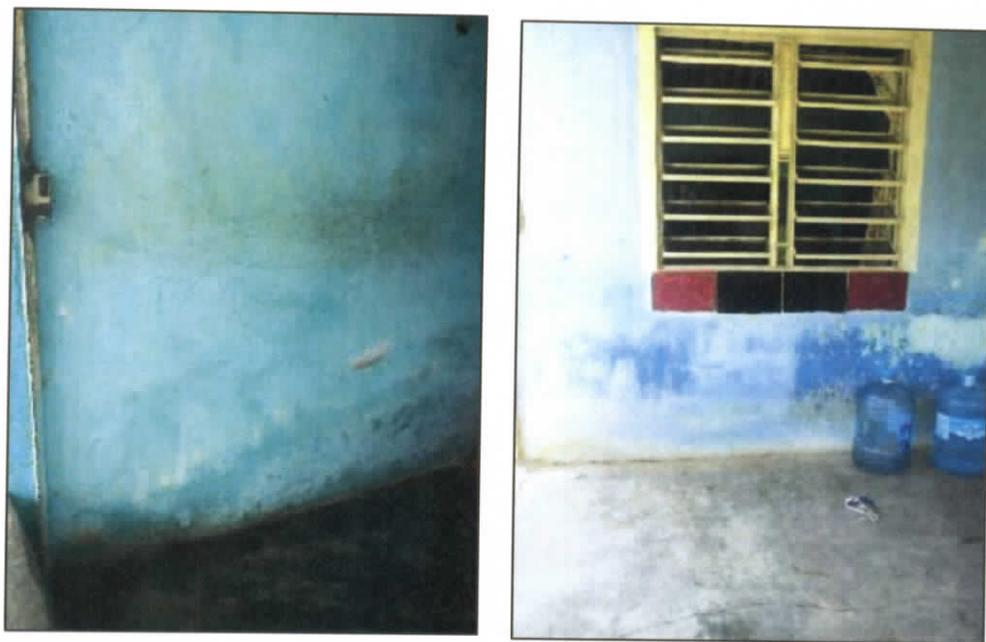
**Figura 11.27.- y Figura 11.28.- Estas viviendas de la localidad Zapotal 1ra. Sección, registran un tirante de inundación de hasta 40 cm. Municipio de Comalcalco.**
