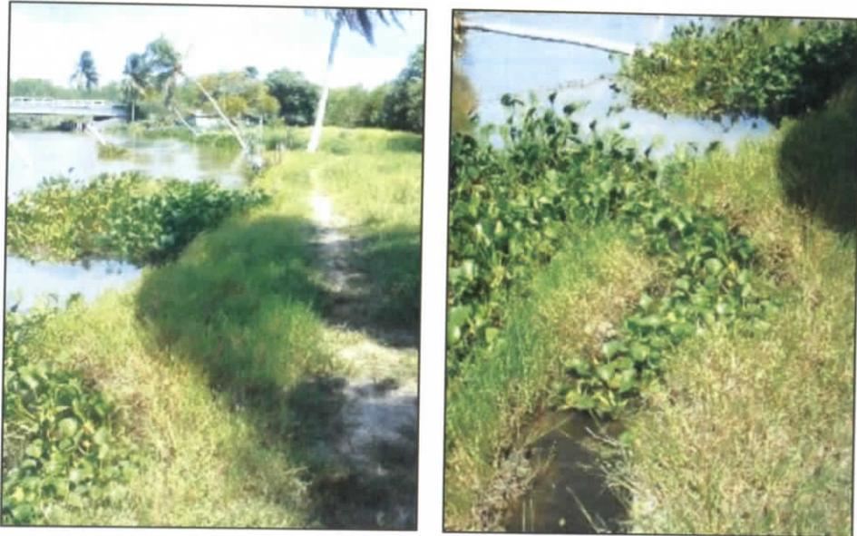
**Figura 11.35.- y Figura 11.36.- Uno de los problemas detectados en la localidad La Solución Somos Todos (Arroyo Hondo), es la erosión que se presenta sobre la margen del río, lo cual está propiciando complicaciones de acceso entre las viviendas y la carretera. Municipio Jalpa de Méndez.**
