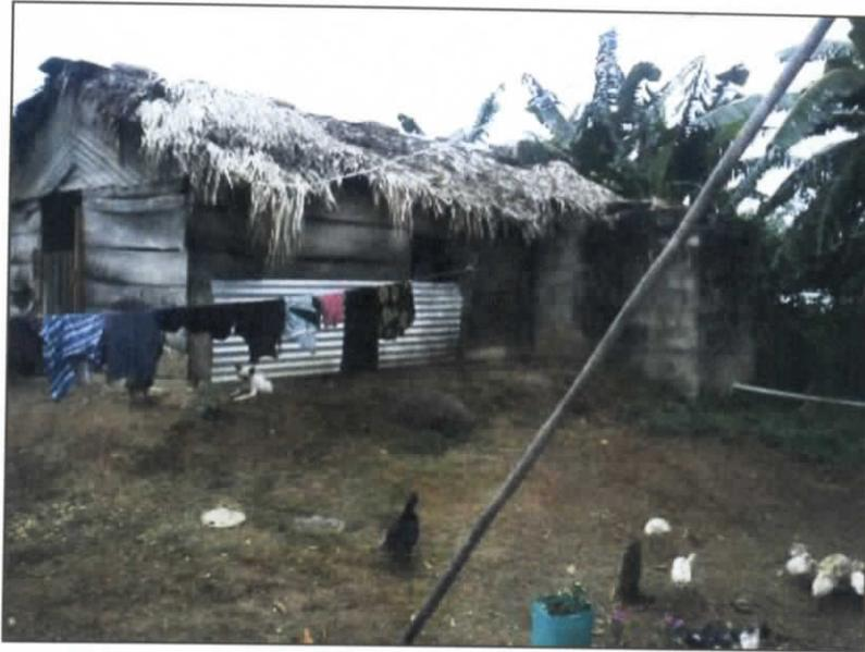
**Figura 11.48.- Vivienda en la localidad Bitzal 4ta. Sección, en donde se aprecia una medida adaptativa, mediante los rellenos, a modo de terraplenes para asentar la construcción. Esta vivienda se localiza a la margen del río Bitzal. Municipio de Macuspana.**
