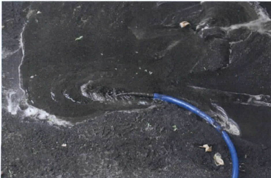
Figura 9.105 Descarga de la bomba sumergible (nótese la gran descarga de sedimento)
