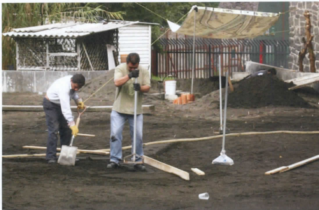
Figura 9.44 Compactación para nueva topografía
