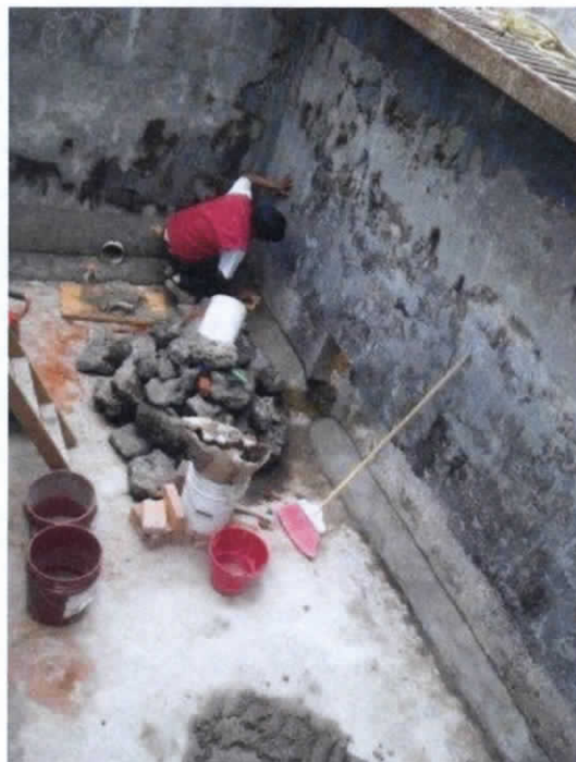
Figura 9.39 Trabajos de mantenimiento en tanques
