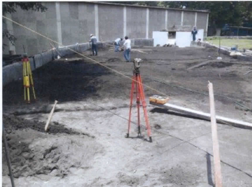
Figura 9.41 Revisión y nivelación del terreno
