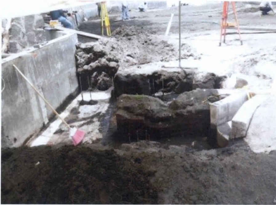
Figura 9.42 Construcción de la margen derecha
