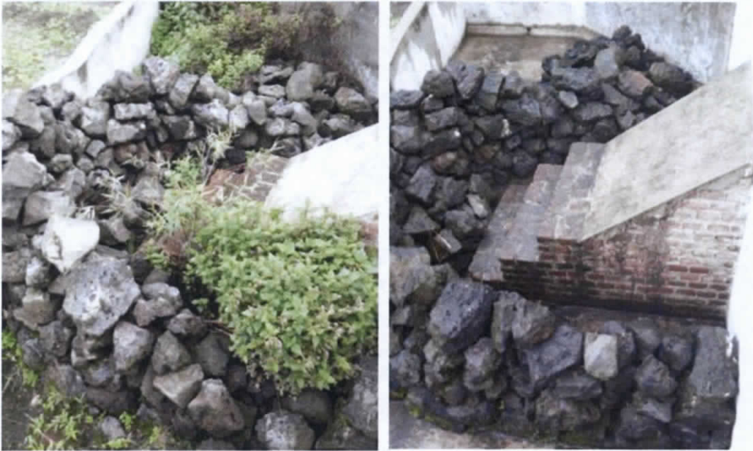
Figura 9.38 Retiro de vegetación y limpieza del tanque de disipación
