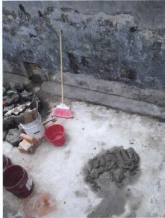
Figura 9.40 Colocación de chaflanes para evitar fugas
