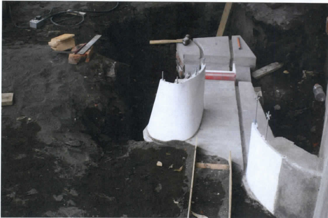
Figura 9.47 Elementos impresos canal margen derecha
