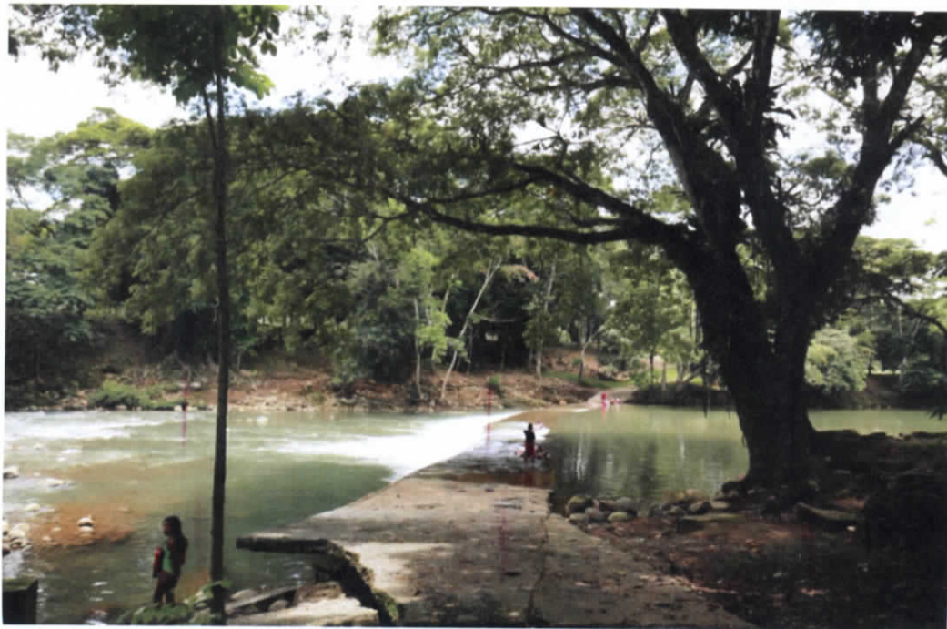
Figura 7.293.- Fotografía-E_5D4212.JPG (FUENTE: IINGEN, 2014)
