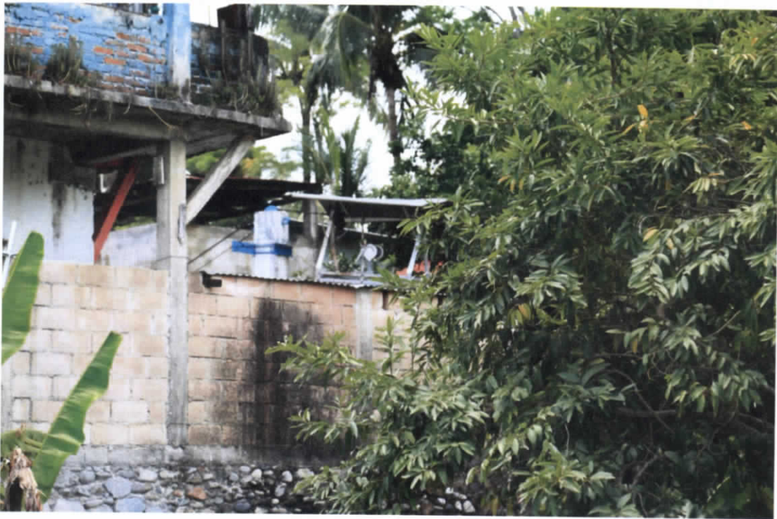
Figura 7.290.- Fotografía-E_5D4165.JPG (FUENTE: IINGEN, 2014)
