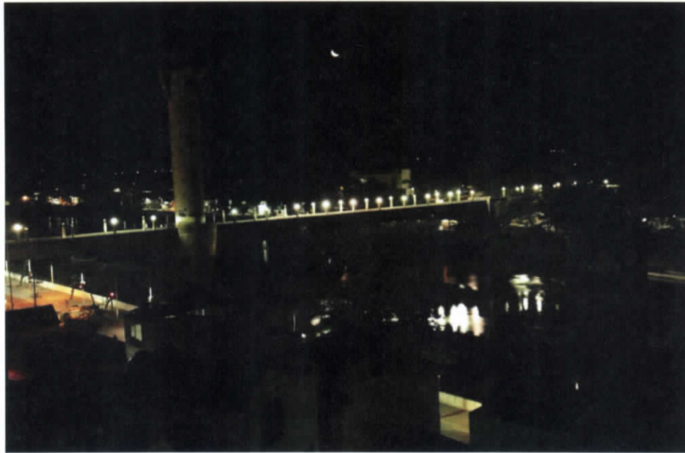
Figura 7.351.- Toma fotográfica de un puente-E_5D5403.JPG (FUENTE: IINGEN, 2014)
