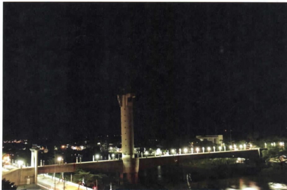
Figura 7.348.- Toma fotográfica de un puente-E_5D4221.JPG (FUENTE: IINGEN, 2014)
