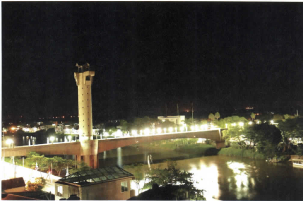
Figura 7.349.- Toma fotográfica de un puente-E_5D4227.JPG (FUENTE: IINGEN, 2014)
