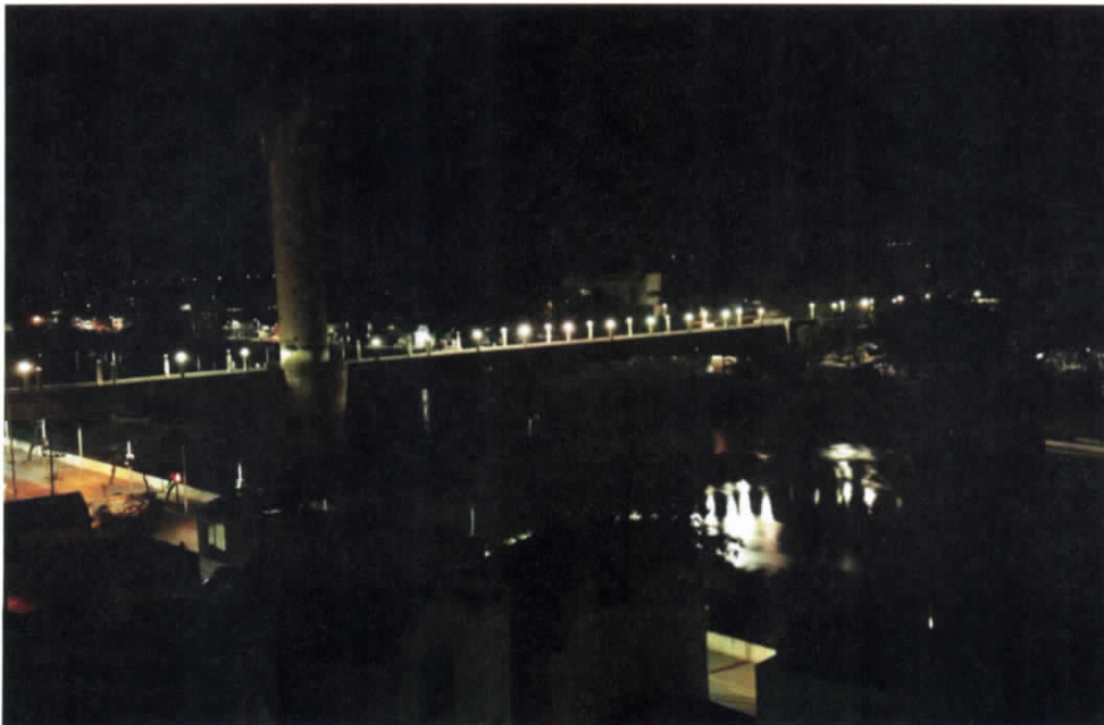
Figura 7.352.- Toma fotográfica de un puente-E_5D6003.JPG (FUENTE: IINGEN, 2014)
