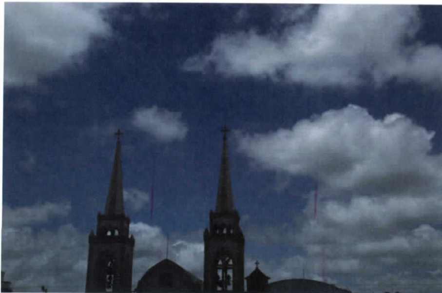
Figura 7.21.- Toma fotográfica de la catedral de Frontera- E_5D7385.JPG (FUENTE: IINGEN, 2014)
