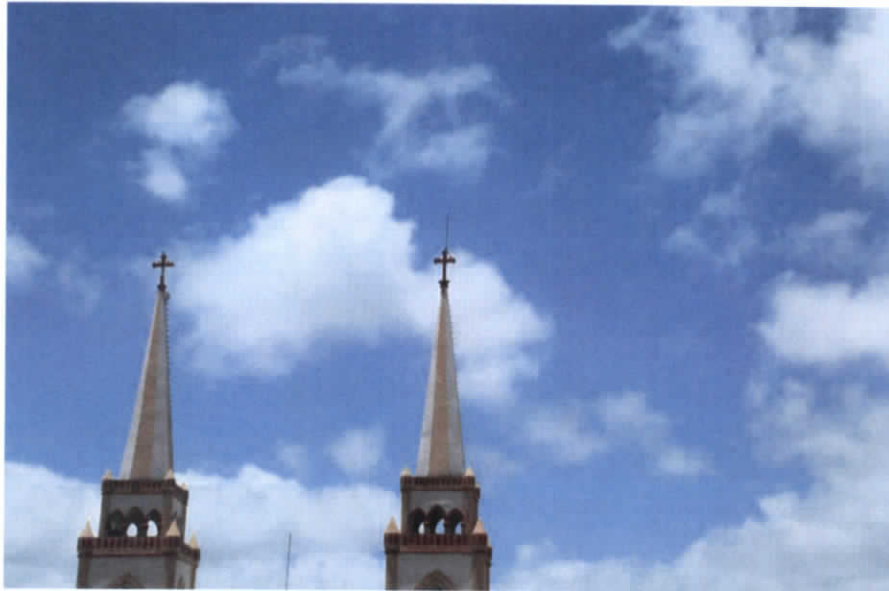
Figura 7.20.- Toma fotográfica de la catedral de Frontera- E_5D7372.JPG (FUENTE: IINGEN, 2014)
