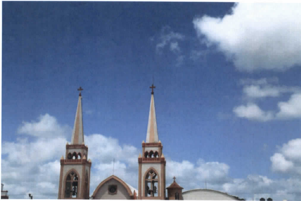
Figura 7.24.- Toma fotográfica de la catedral de Frontera- E_5D8340.JPG (FUENTE: IINGEN, 2014)
