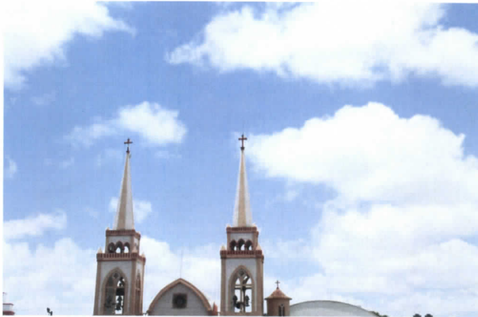
Figura 7.22.- Toma fotográfica de la catedral de Frontera- E_5D7394.JPG (FUENTE: IINGEN, 2014)
