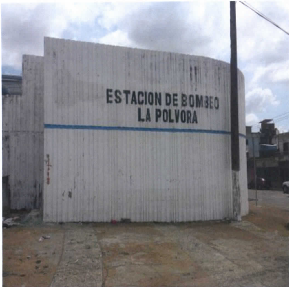
Figura 3.9.5. Punto Estación de bombeo la pólvora. (Instituto de Ingeniería, 2014).
