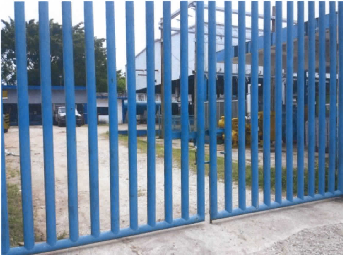
Figura 3.9.6. Punto Estación de bombeo la pólvora. (Instituto de Ingeniería, 2014).
