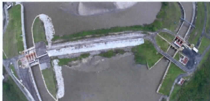
Fotografías generales de la Estructura de control "El Macayo"
