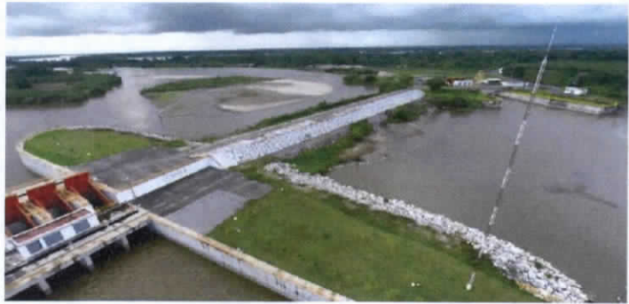
Fotografías generales de la Estructura de control "El Macayo"
