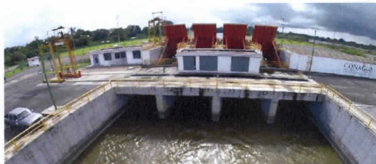
Fotografía compuertas radiales Margen Derecha
