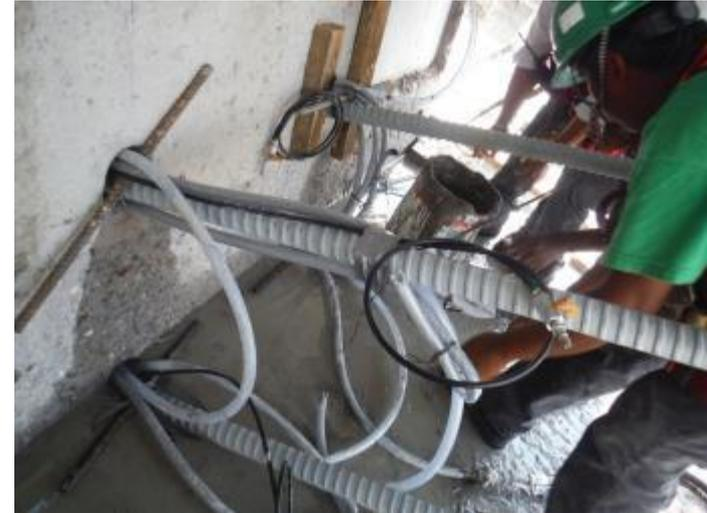
Inyección de barrenos para anclas de presfuerzo en lecho inferior de viga testera 7
