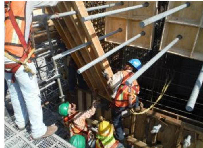
Colocación de cimbra frontal para bloque de empaque de viga testera 7
