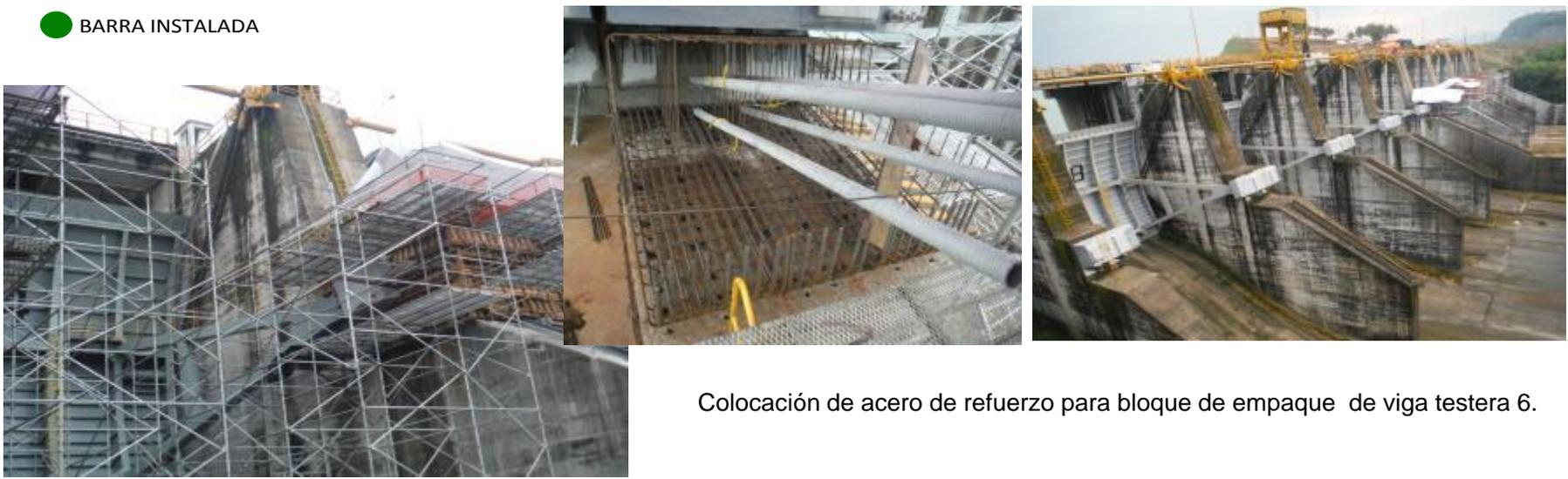
Colocación de acero de refuerzo para bloque de empaque de viga testera 6.
