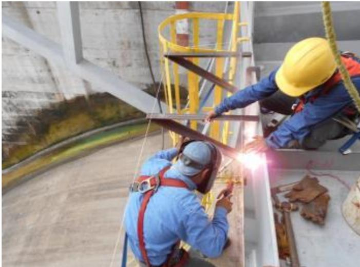
Colocación de estructura para pasarela y barandal en compuertas radiales
