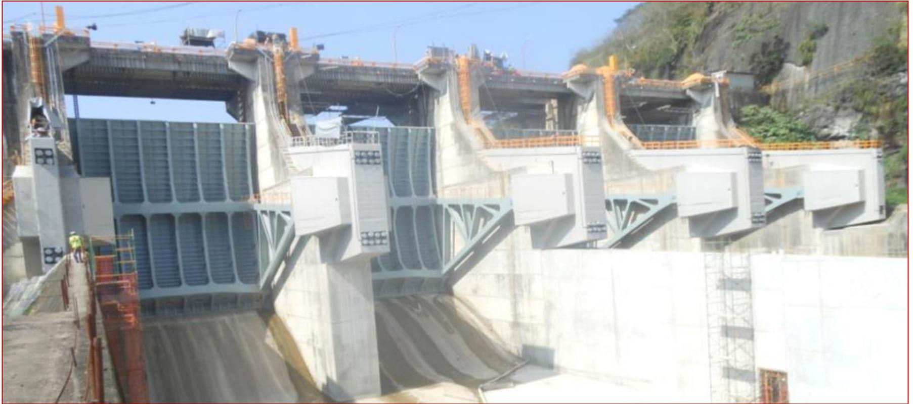
**A la fecha se tienen concluidos los trabajos de reforzamiento de las Vigas testeras, el reforzamiento de las compuertas, terminado el muro central y se están concluyendo los trabajos del aperaltamiento y aireadores, se estima terminar los trabajos en el mes de mayo.**
