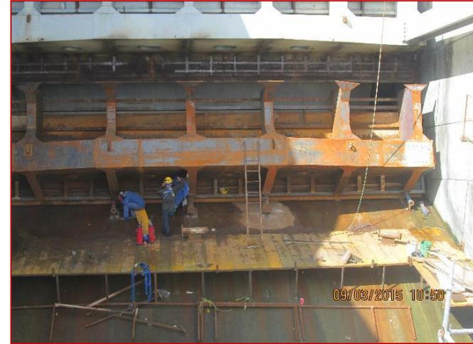
Continúa el ajuste y nivelación de la nueva sección de pantalla en la compuerta radial n.º 6.
