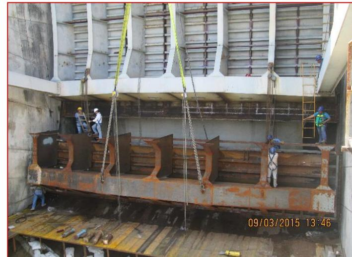
Montaje de la nueva sección de pantalla para el incremento de altura de la compuerta radial n.º 7
