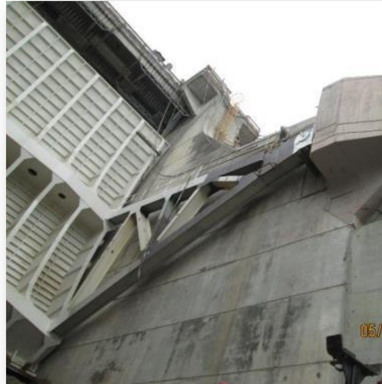
Sandblasteo y aplicación de primario brazos compuerta 3.
