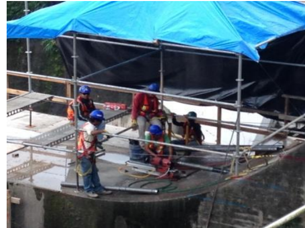
Perforación de barreno 2 en viga testera 6
