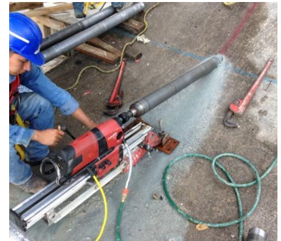
Perforación de barreno 2 en viga testera 6
