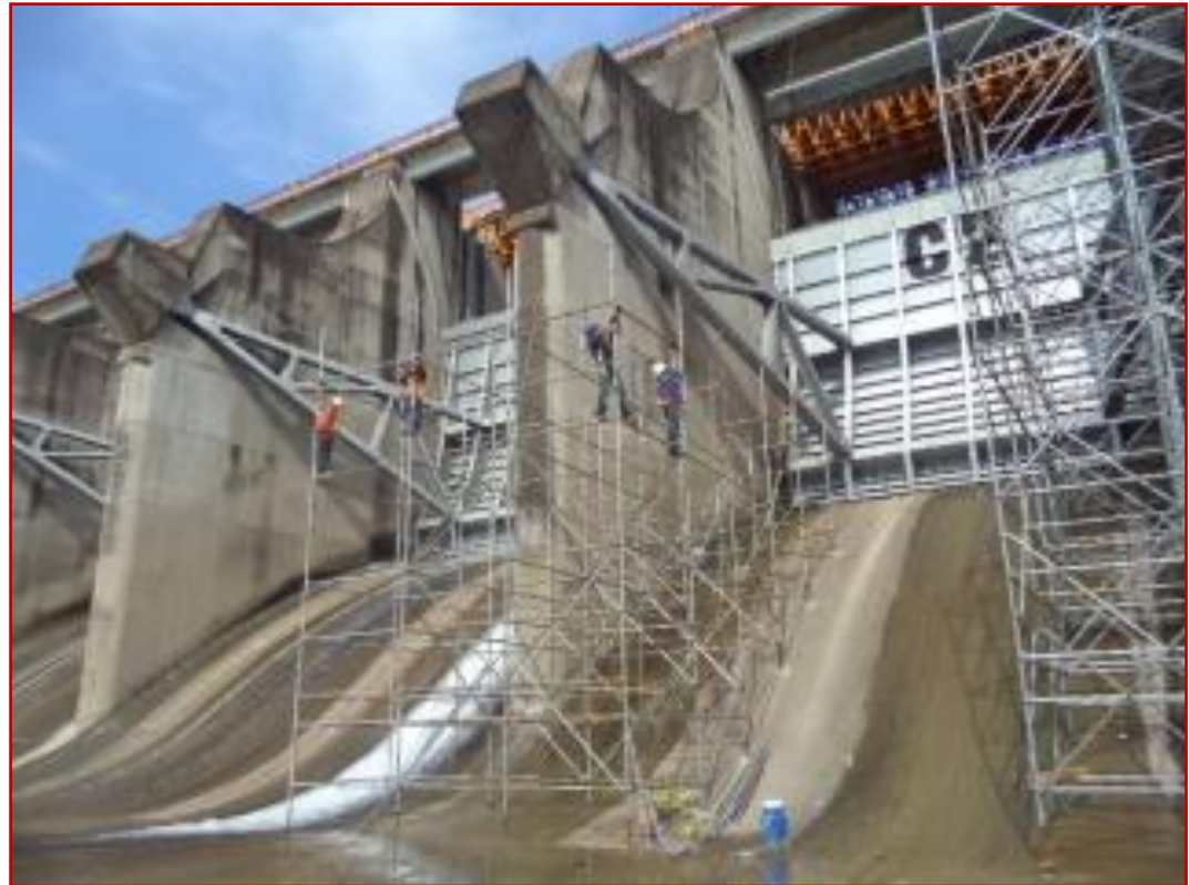
Colocación del andamiaje en la viga testera 03.
