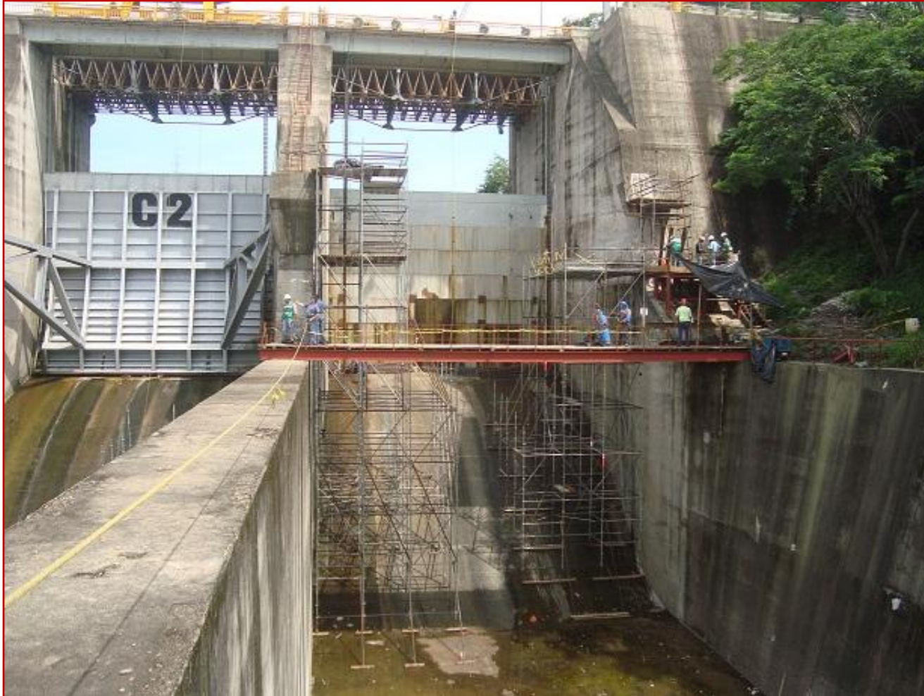
Trabajos de restitución de viga testera 1 y preparativos para colocación de presfuerzos en viga testera 2.
