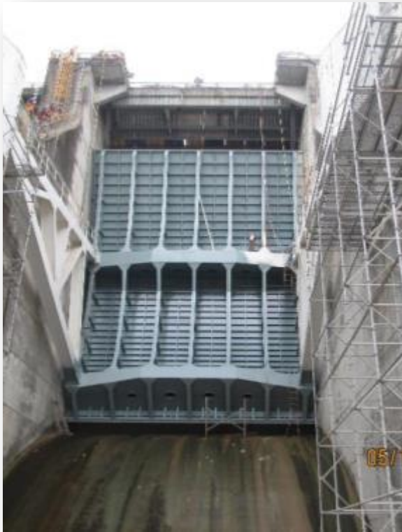
Aplicación de acabado compuerta 4.
