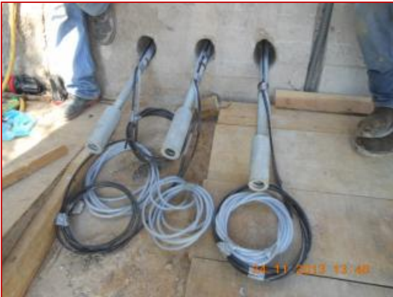
Colocación de anclas en la viga testera 2 y 8.
