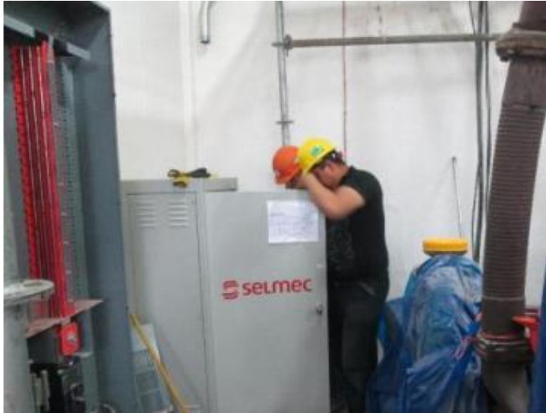
Mantenimiento de equipos eléctricos
