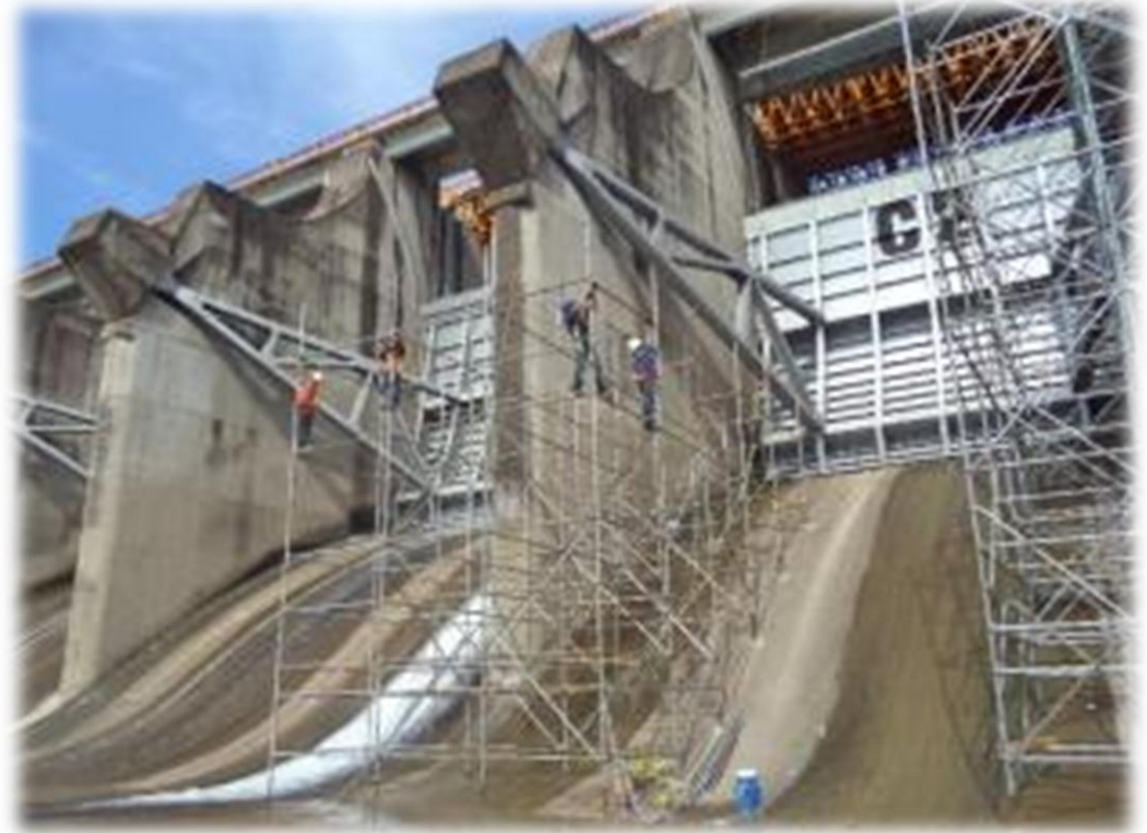
Colocación del andamiaje en la viga testera 03.
