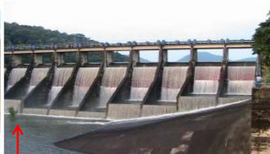
Árbol dentro del tanque amortiguador
